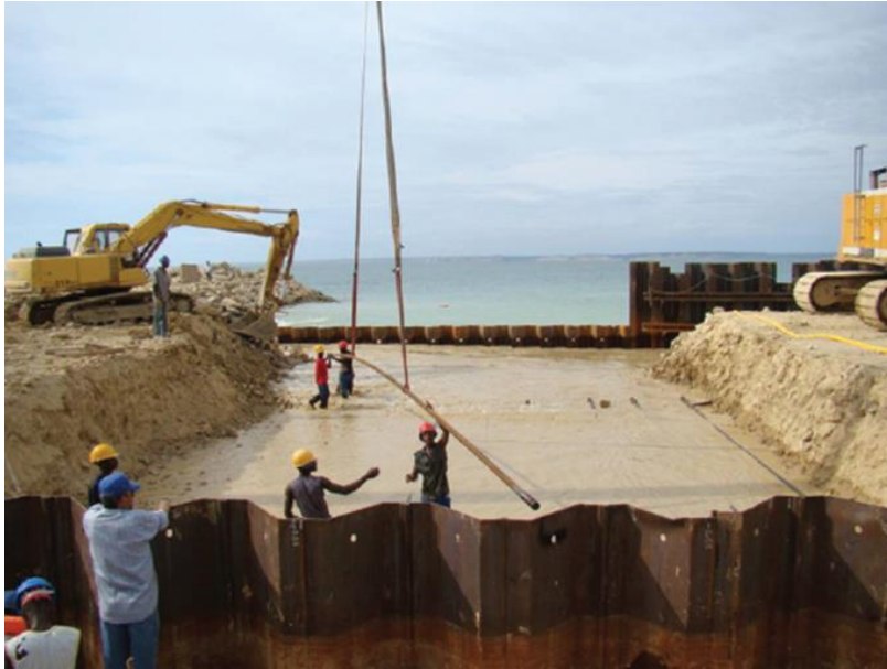
Figure 13 : Exemple de mise en place de tirants entre un rideau principal et son rideau d'ancrage NB : le chantier illustré est de taille supérieure à celui associé au projet (Source : Egis Ports, 2016)
