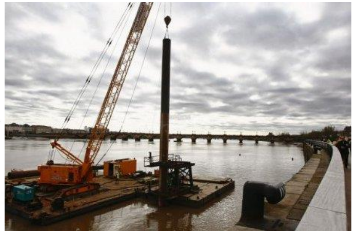
Figure 14 : Schématisation et exemple de mise en place de pieux par barge (Source : Egis Ports, 2016)
